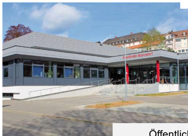
Bonndorf: Sanierte Stadthalle Foto: Plan und Praxis
